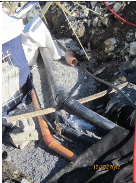
Figur 30 Bend på PE-rør. Foto: Terje Rønneberg
