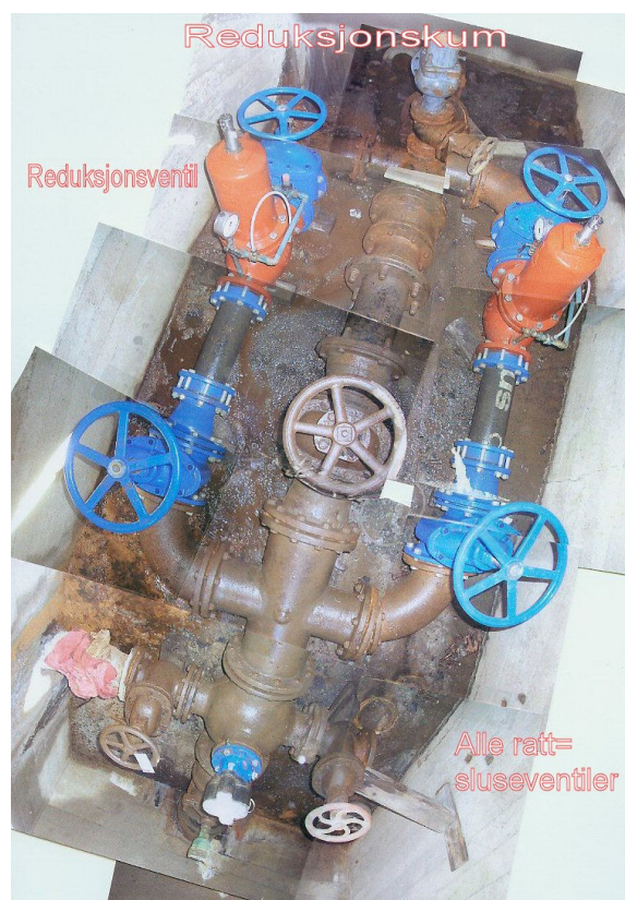
Figur 27 Reduksjonskum med reduksjonsventil. Foto: Terje Rønneberg.
