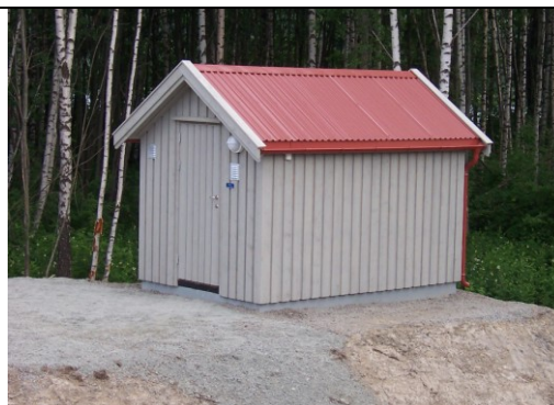
Figur 17 Nettverksstasjon. Foto: NOIS/Tore Paulsen
