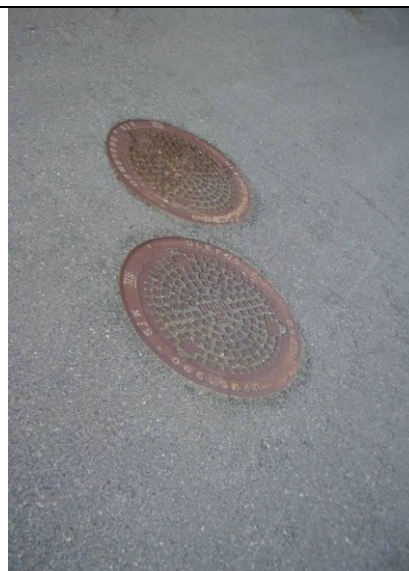
Figur 12 Kumlokk – det synlige i vegbanen. Kilde: FKB
