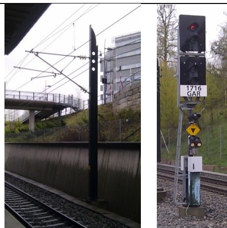
Figur 14 Kontaktledningsmast (t.v.) og signalmast (t.h.). Foto: Jernbaneverket
